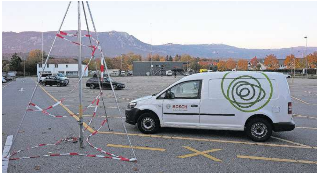
Parkplatz hinter dem Personalrestaurant der Scintilla: Der Neubau ist bereits ausgesteckt.
